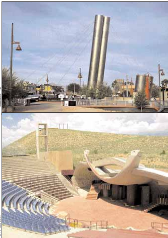
Tra inaugurazioni e minacce di demolizione. Il ponte e la piazza pedonale circostante ultimati l'11 dicembre a Scottsdale su disegno di Paolo Soleri; il suo anfiteatro nel campus della Santa Fe Indian School (1964-1970)
